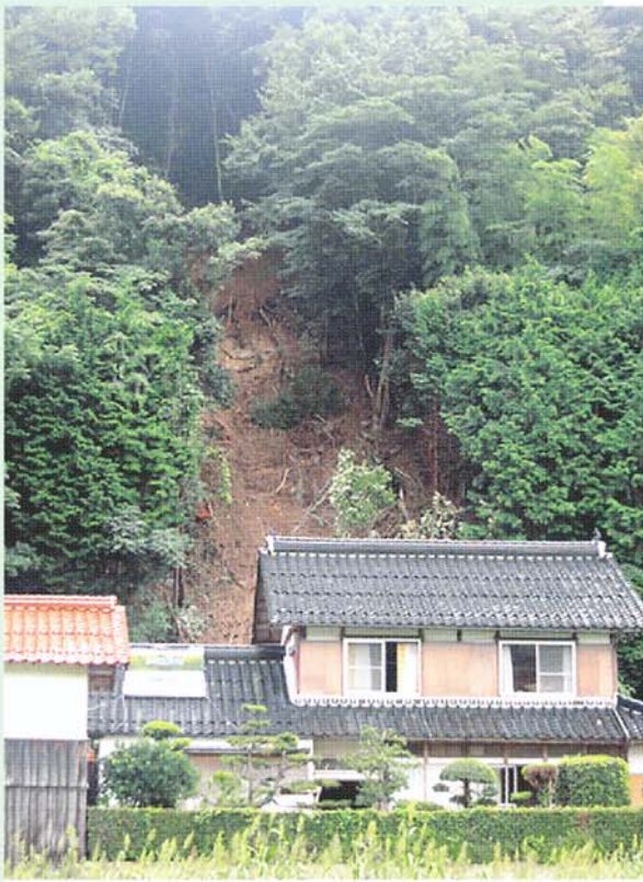
救出活動を行った土砂災害現場。高さ40mにわたり裏山の土砂が崩れ、家屋に流れ込んだ
