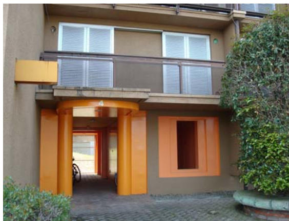
② その瀟洒なエントランス
