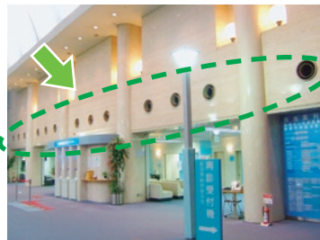
ホール吹き出し口
