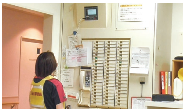
火災発生通報（病棟）
