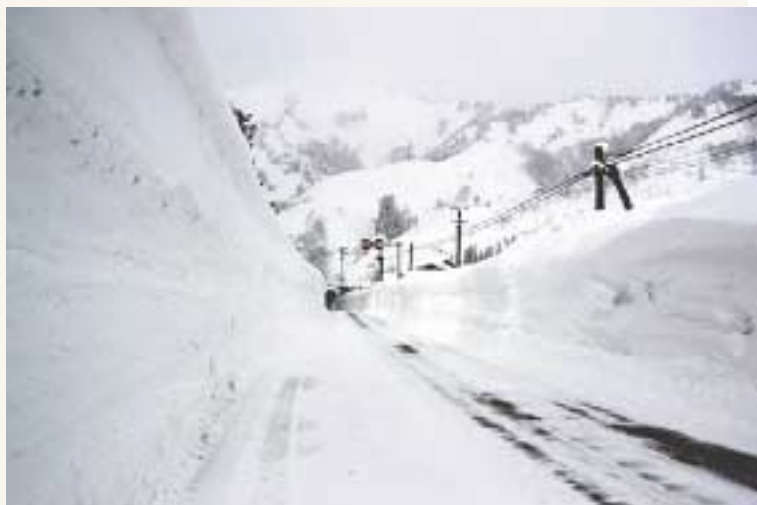
冬の国道。道路脇の雪壁の高さは3mを越える
