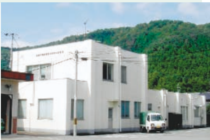
旧朽木村の一番の繁華街にある朽木診療所。旧朽木村役場（現高島市朽木支所）に隣接する
