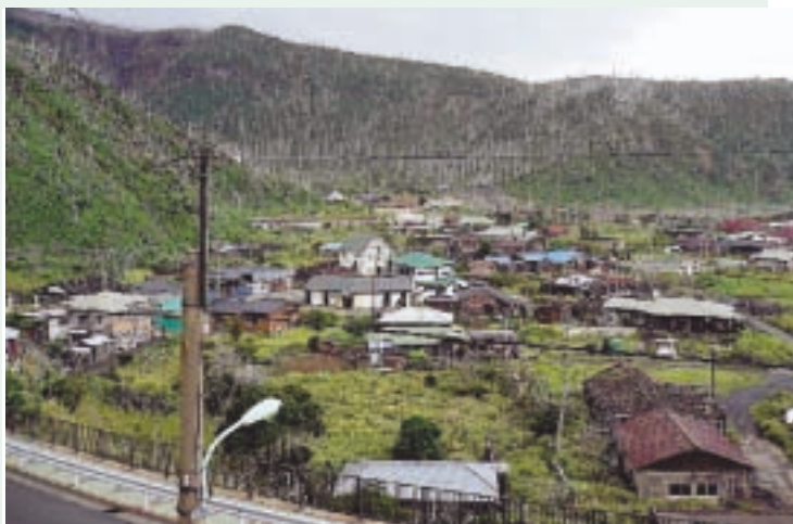
火山ガスの高濃度地区内の集落。まだ居住が許可されず、崩壊の激しい家屋が目立つ
