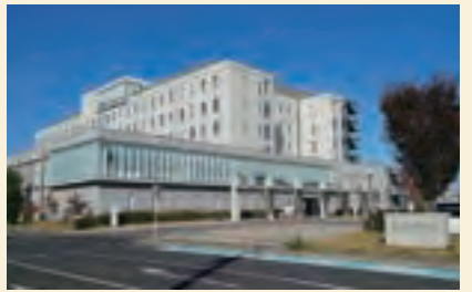
■ とちぎメディカルセンターしもつが（栃木県栃木市）
