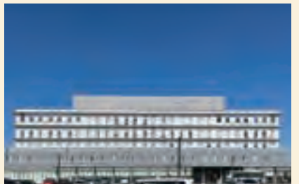
■ 茨城県西部メディカルセンター（茨城県筑西市）
